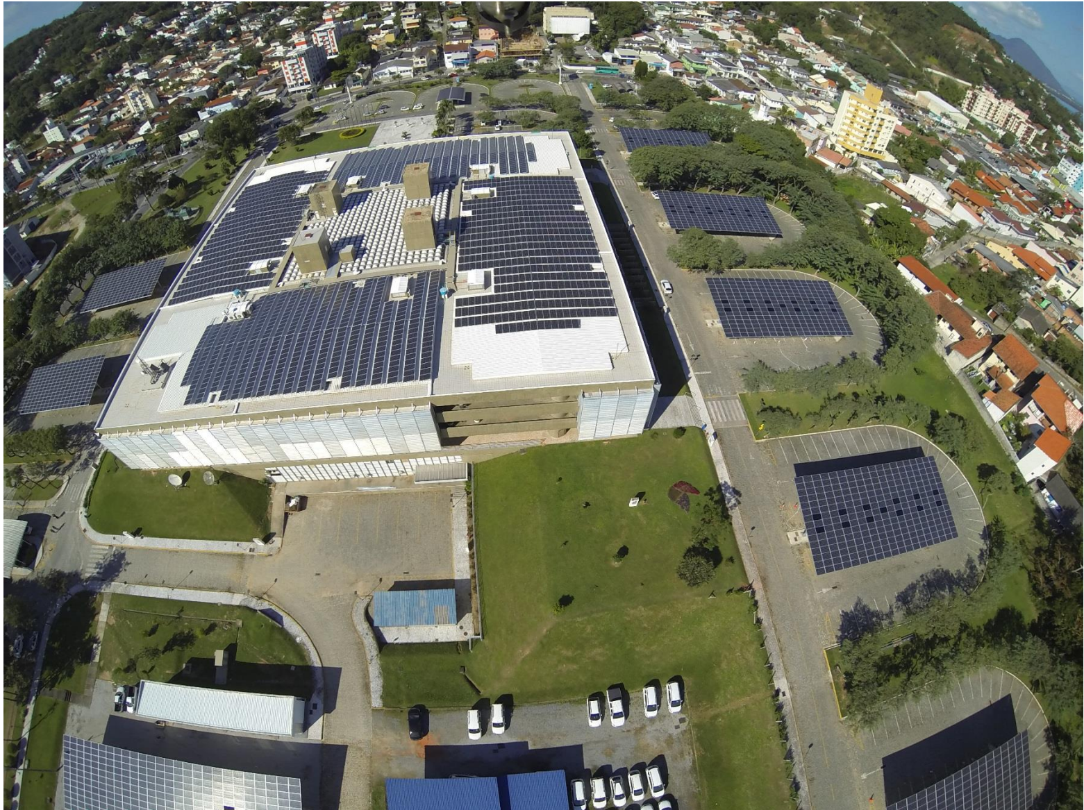
ELETROSUL Megawatt Solar cobertura do Edifício Sede da Eletrosul e estacionamentos - 2014
